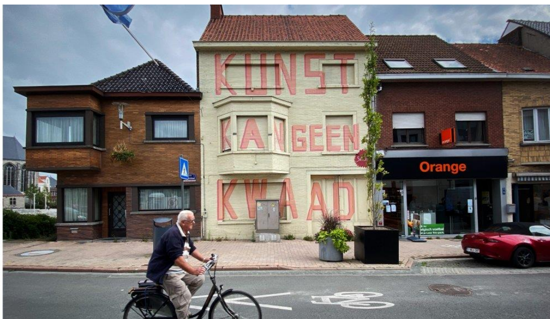
De hoekhuizen (september 2020) - toestand vóór de sloop (Foto: Rik Van Puymbroeck).
