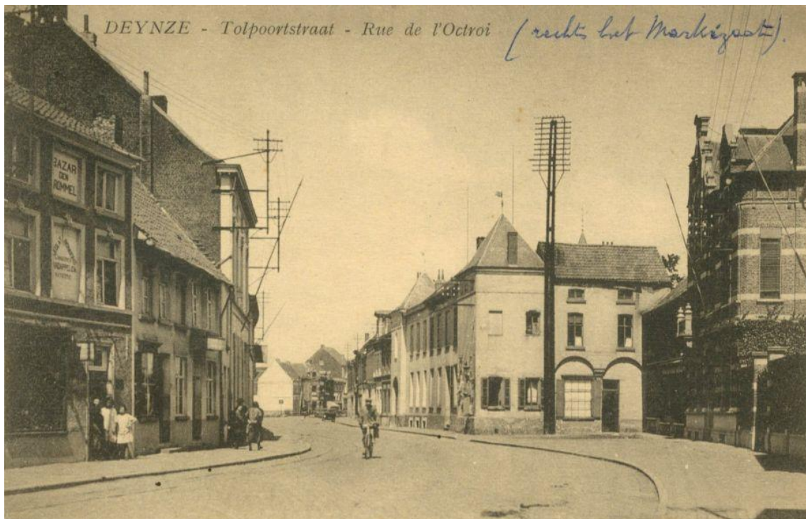
Voorbij de straatbocht, nog iets dichter naar de Knok toe (Coll. Mudel - waarvoor dank). Op deze foto, die links de huizen tot vooraan in de straatbocht weergeeft, wordt de rechterkant van de foto gedomineerd door de imposante zuidgevel van het oude Markiezaat, met een huizenhoge elektriciteitspaal op het ervoor liggend pleintje.
